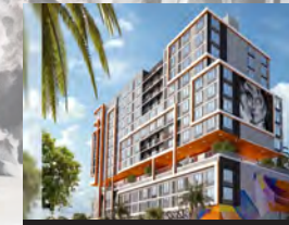
2000 N. MIAMI AVE CLEARLINE 300 UNITS
