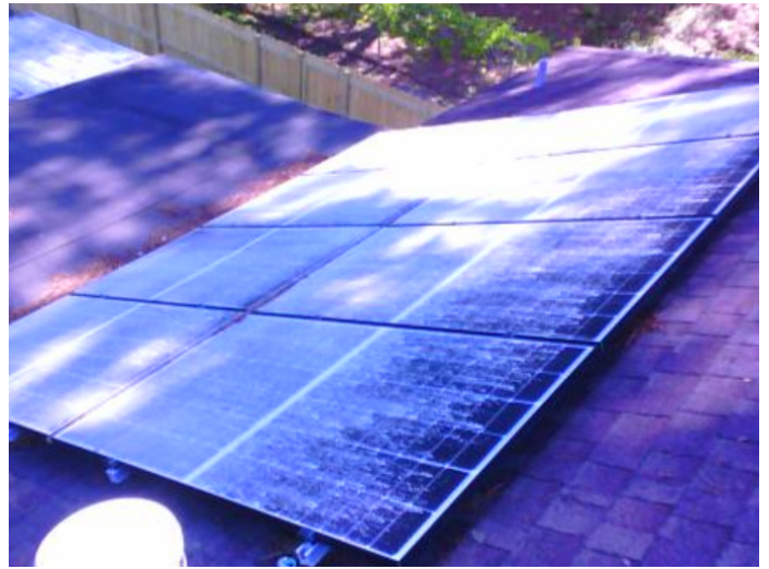
DC - FLIR0216 .jpg
