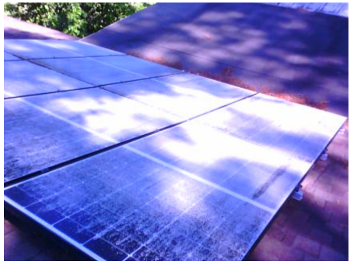
DC - FLIR0218 .jpg
