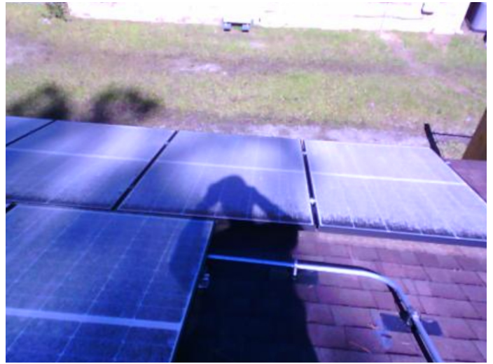
DC - FLIR0222 .jpg
