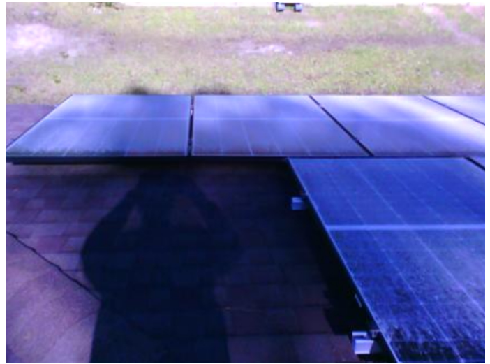
DC - FLIR0220 .jpg
